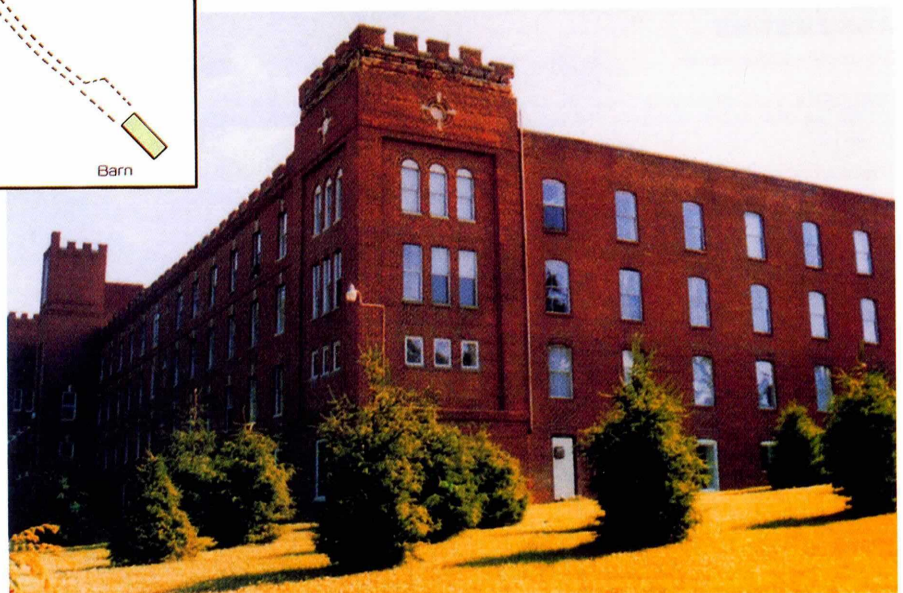
北側からみた本館 Main Building
