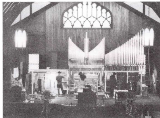
チャペルに設置中のパイプオルガン (1966年) Installing the chapel pipe organ (1966)
