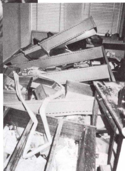
破壊された研究室 Destroyed office
