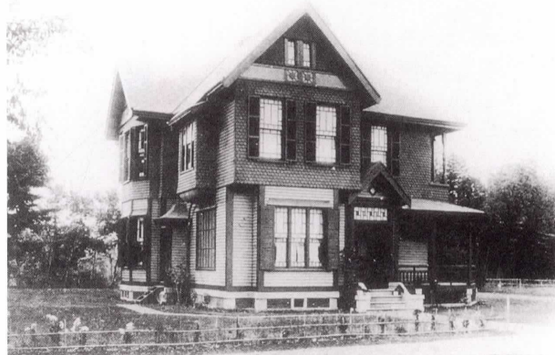
バラ館 Ballagh residence
