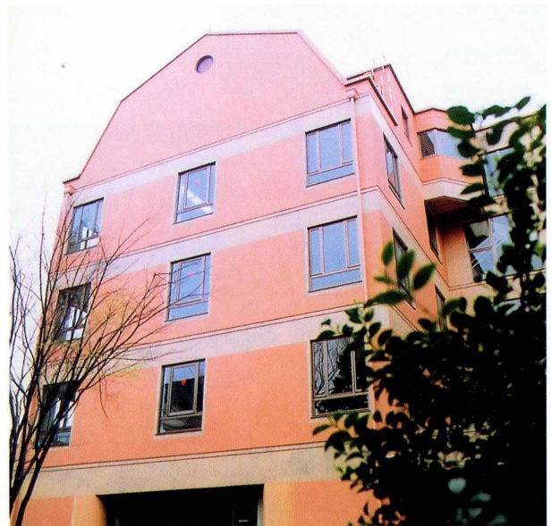
1990年体育館前に高等学校新本館が建築された The new High School Building
