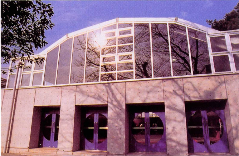
1997年完成の道場 Training Hall completed in 1997
