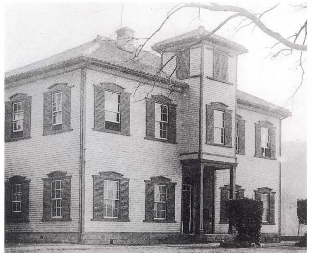
東山学院校舎 (現在グラバー邸裏に保存されている)
