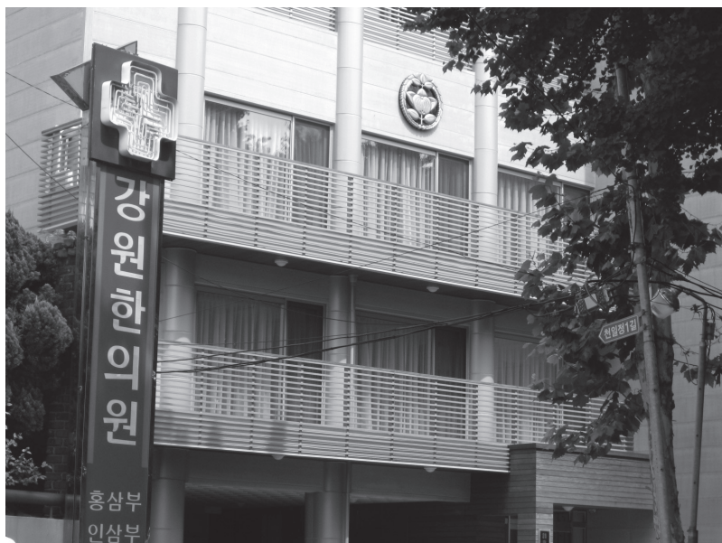
写真21 リフォームして新しくなった教会道場の外観
