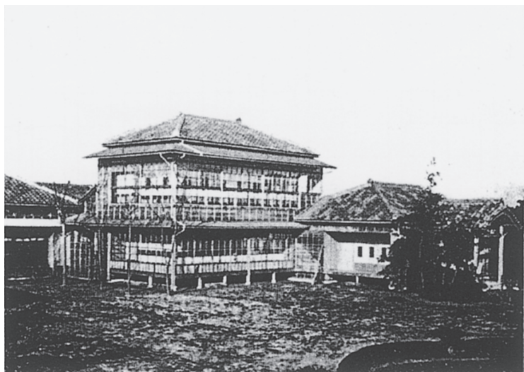
東京育成園駒沢分園（第二期工事の後）
