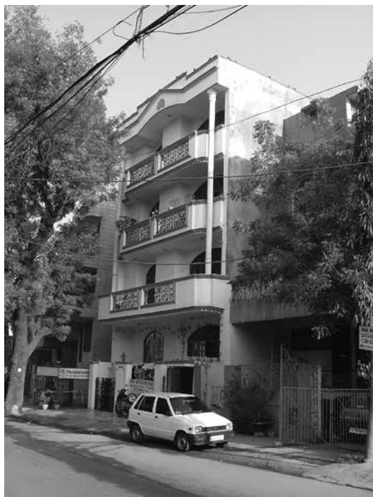
写真1 DDC外観 (2004年 立正佼成会提供) 中央の建物の4階と半地下部分を賃借していた。
